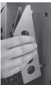
Извлечение перегородки из лотка DH8.
