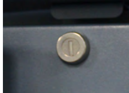
Afbeelding 18 (links): Monitoringsysteem/toegangscntrole schakelaar reservebatterij (omcirkeld).
