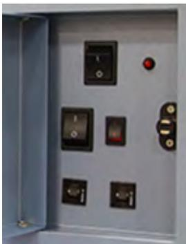
Figura 4: interruptor ENCENDIDO/APAGADO de CA (parte superior, en medio), interruptor ENCENDIDO/APAGADO de la batería de reserva del sistema de monitorización/control de acceso de i.C<sup>3</sup> (a la derecha, en el centro), disyuntores (parte inferior).
