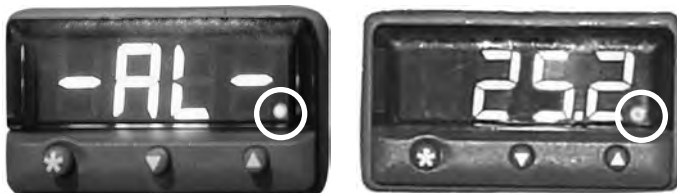
Temperatuur monitor/controller in alarmtoestand (rode lampje omcirkeld).
