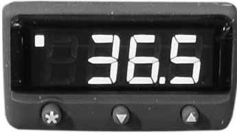
Display della centralina della temperatura.
