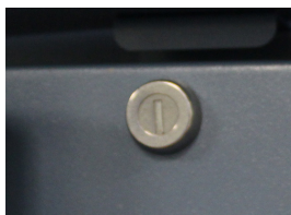
Afbeelding 18 (links): Monitoringsysteem/toegangscontrole schakelaar reservebatterij (omcirkeld).
